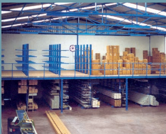
Tárológaléria karos állványrendszerű köztes szintként. Felül: csomagok tárolása és részben polcozás.
