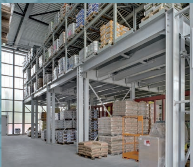
Robusztus acél tárológaléria egy építőanyag-raktárban. Beépített szállítástechnikával hengerpályák beépítésének köszönhetően.
